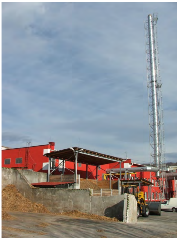
Obrázok 1. Drevný popol vzniká ako silne zásaditý odpad po energetickom využití dendromasy. Na obrázku centrálny zdroj tepla na palivové štiepky v Žarnovici.
